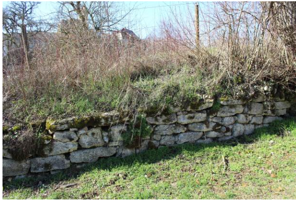
Trockenmauer im östlichen Bereich. Hier ist sie am wenigsten überwachsen und bemoost.
