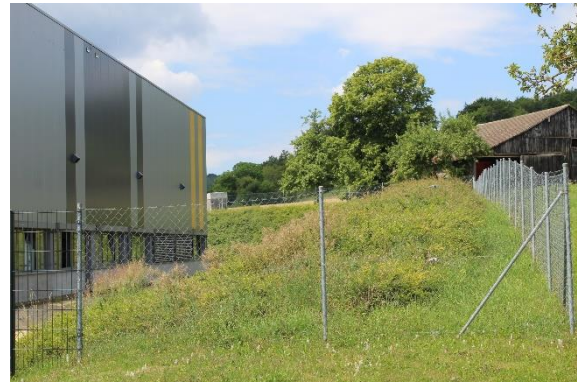
Nördlicher Rand des Betriebsgebäudes mit angrenzender der mit Bodendeckern bewachsenen Böschung.
