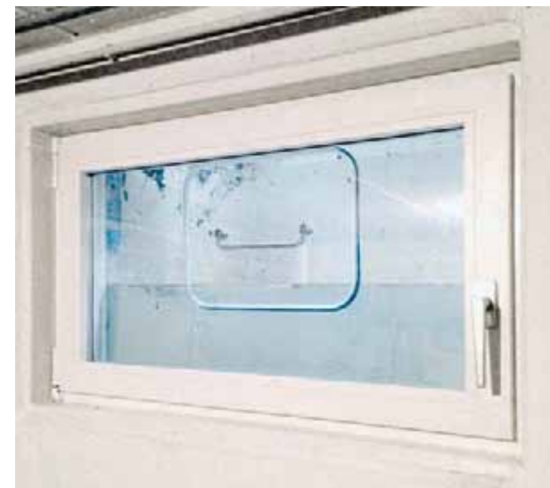
Nachträglicher Einbau von Vorsatzscheiben
