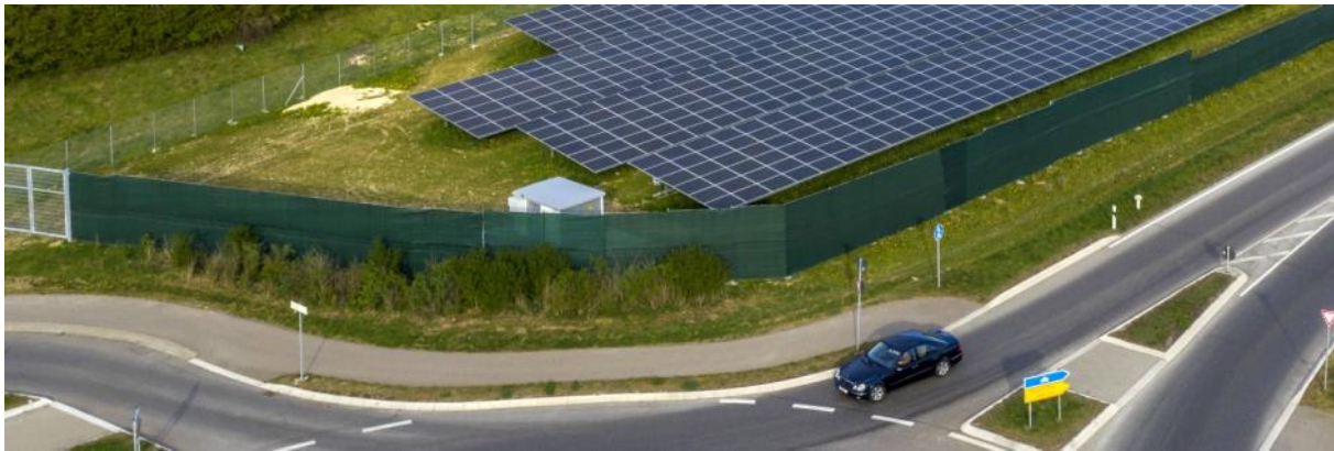
Abb. 18: Beispiel einer als Blendschutz dienenden Zaunanlage, mit Gewebeplane bespannt und durch Sträucher eingegrünt (Solarpark Engen, projektiert von solarcomplex, Foto: Plattform EE BW / Kuhnle & Knödler)
